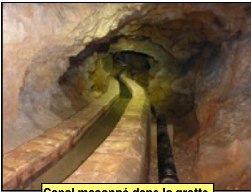
Canal maçonné dans la grotte
